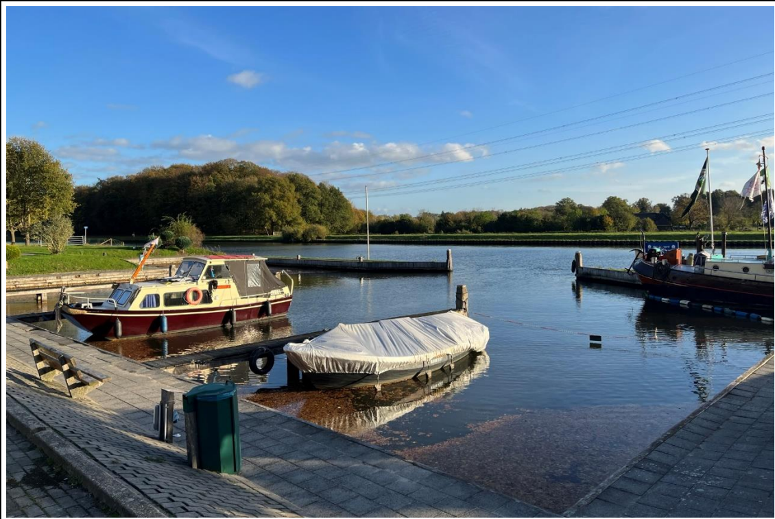
Figuur 8 – Passantenhaven bij de Nieuwe Aanleg
